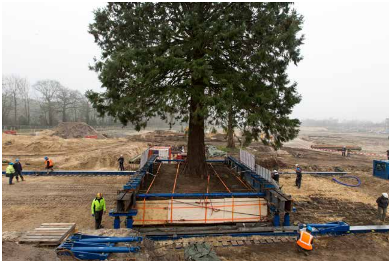
Bij grote bomen wordt de kluit eerst gefixeerd. Deze Mammoetboom is met de vijzelmethode verplant.
