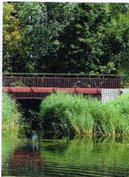
Een van de tien door Lia Copijn ontworpen bruggen op het terrein.
